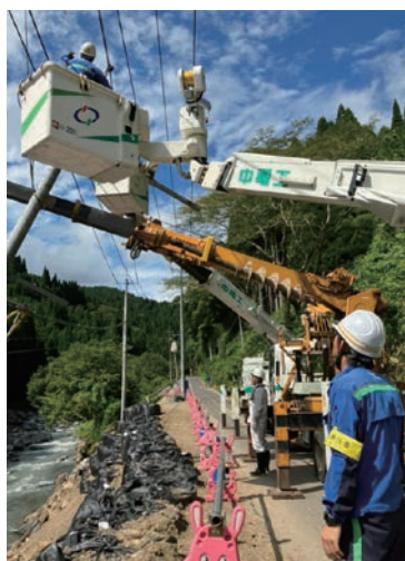
復旧作業の様子
